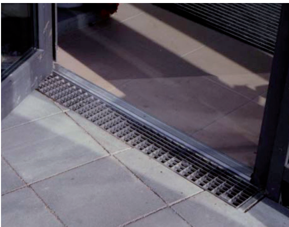
Bild 4 Schwellenfreier Zugang mit Wassersammelrinne und Gitterrost
