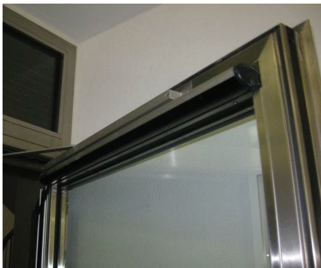
Bild 7 Infrarotvorhangsschiene zur Anwesenheitskontrolle (Quelle linkes Bild: ift Rosenheim, Quelle rechtes Bild: Firma Bircher Reglomat AG, CH-Beringen)
